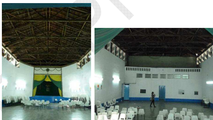
Foto 6. Estado actual del Salón de Actos Colegio del Rosario
