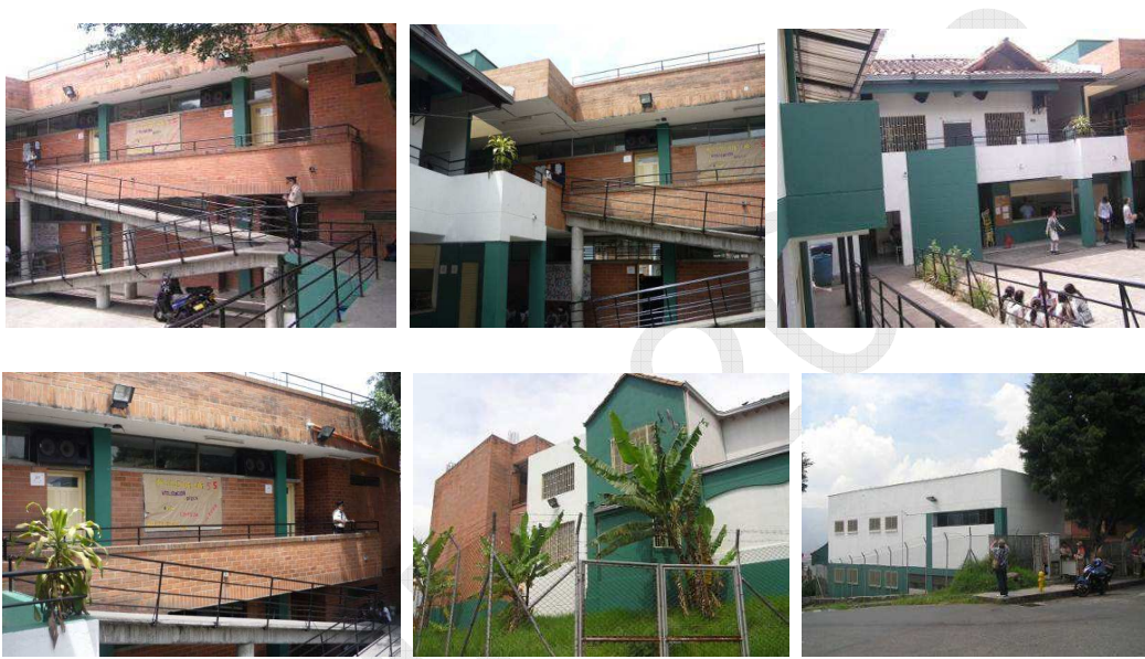
Foto 4. Estado de la ampliación y remodelación a 2012 del antiguo Preventorio
