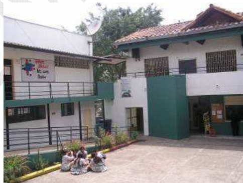
Foto 5. Estado de la edificación a 2012
