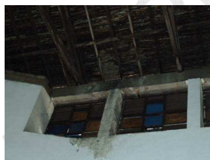
Foto 7. Estado actual del muro del costado sobre la calle 52
